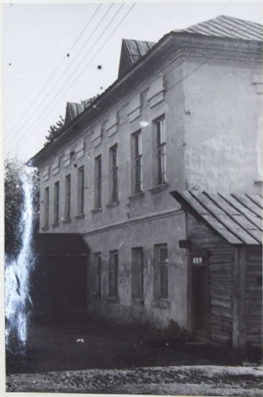
Торцевая часть здания.
