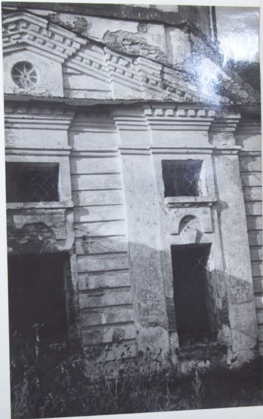
Фрагмент каменного фасада.
